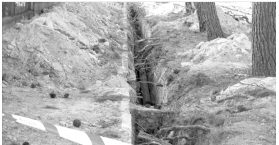
Trabajos en la red de conducción de agua potable al polígono. A.H.
