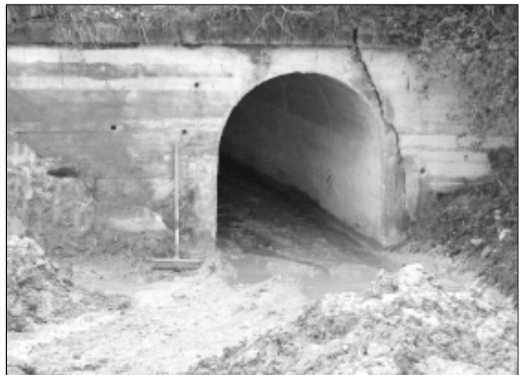
Imagen del colector de "La Mina". A.H.
