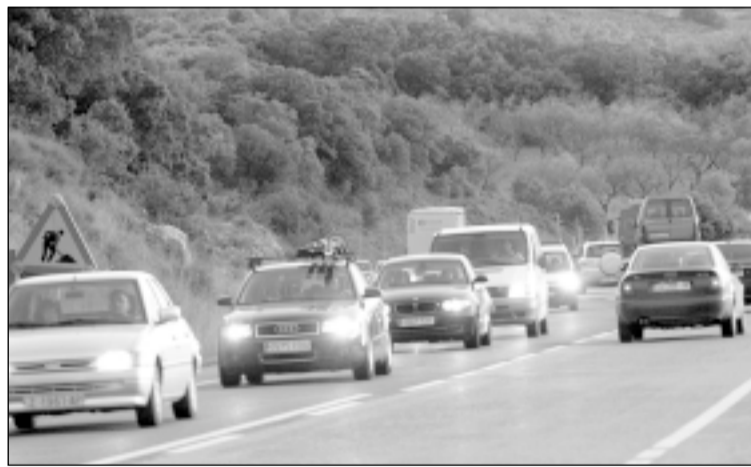
Tráfico en la zona de obras de la autovía a la altura de Nueno. VICTOR IBÁÑEZ
